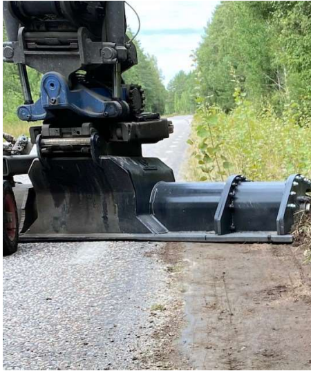
Bild 4, Resultatet efter kantskruven på en mindre väg.
